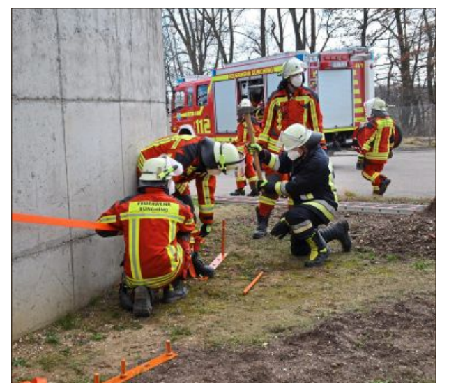
Die Feuerwehr Sünching setzte Bodenanker zur Sicherung der Dachteile. Fotos: Erich Ertl
