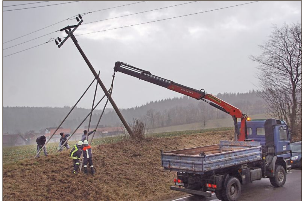
Mitarbeiter der Firma Heider und Aktive der Feuerwehr Hungersacker-Weihern richteten einen Strommast auf, den der Sturm beim Wörther Ortsteil Hungersacker zum Einknicken gebracht hatte. Foto: Simon Stadler
