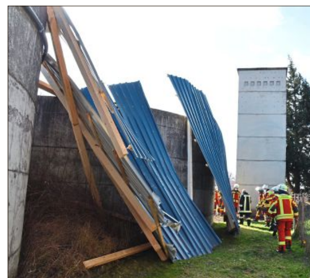
Über die Fahrzeughalle schleuderte der Sturm am Donnerstag die Dachteile.
